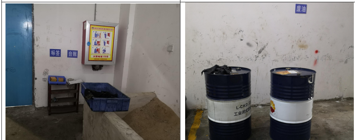
危废暂存库台账存放处及消防措施
