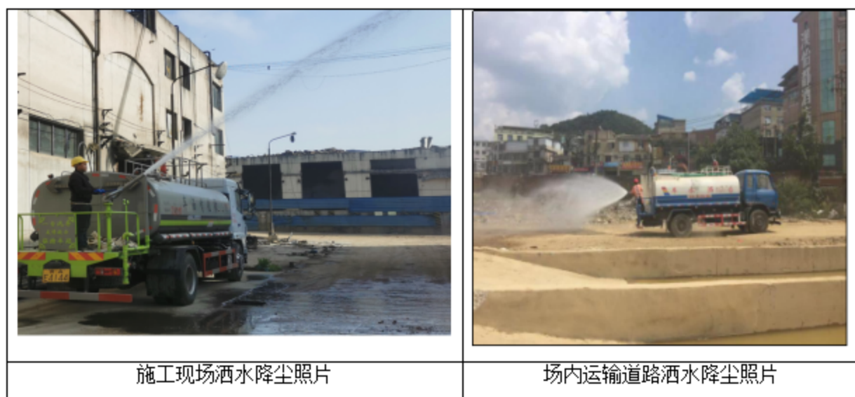
图 3-2 施工方洒水降尘照片
