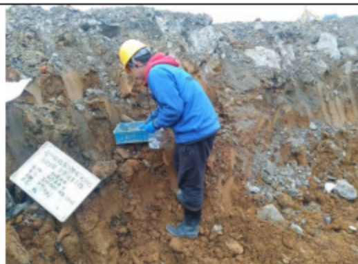
A115(G63-G73)基坑区域侧壁和坑底采样
