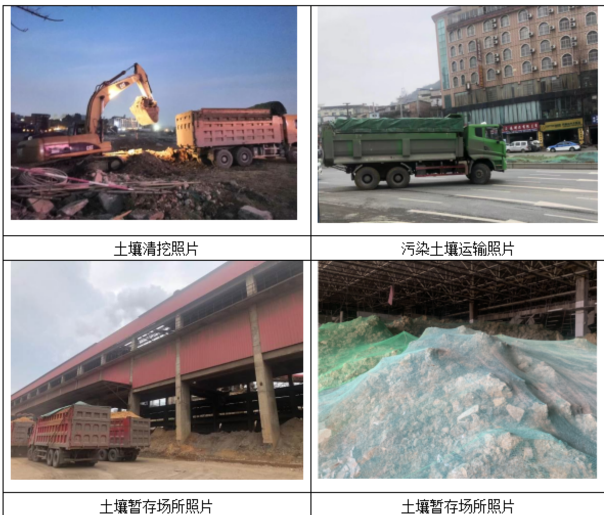
图 3-8 污染土壤清挖及运输照片
